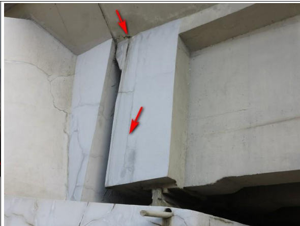
Foto č. 2 - K 01 - kotevní oblast nad O 02 vlevo, v horní části průsak včetně svislé trhliny v pracovní spáře.
