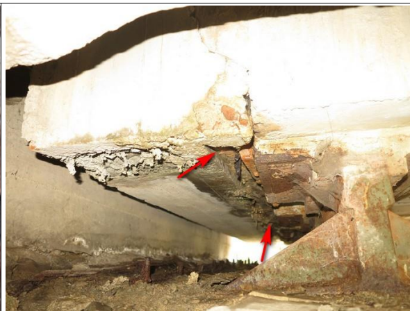
Foto č. 4 - K 02 - kotevní oblast nad O 02 vlevo, silný průsak z podhledu pracovní spáry.
