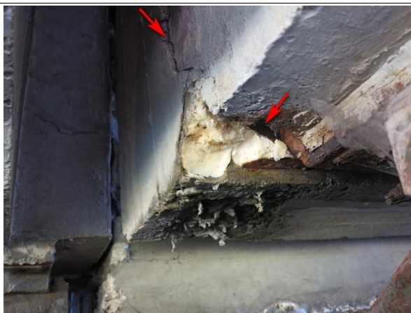
Foto č. 3 - K 02 - kotevní oblast nad O 02 vlevo, trhлина v pracovní spáře (nahore) a průsak (dole). Ve spáře montážní pěna.
