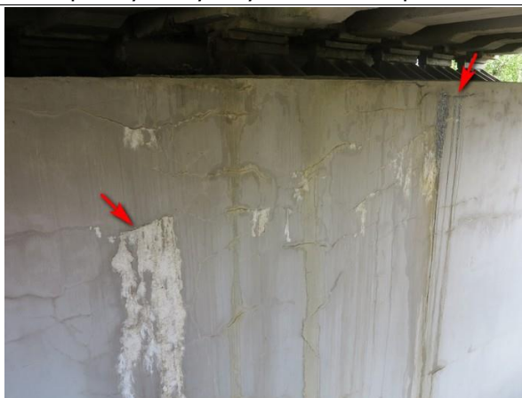
Foto č. 7 - O 02 - z čela dřívku, trhliny s průsaky a vápennými výluhy.
