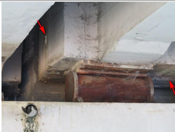
Foto č. 1 - K 01 - kotevní oblast nad O 01 vpravo, trhlina v pracovní spáře včetně mírného průsaku.
