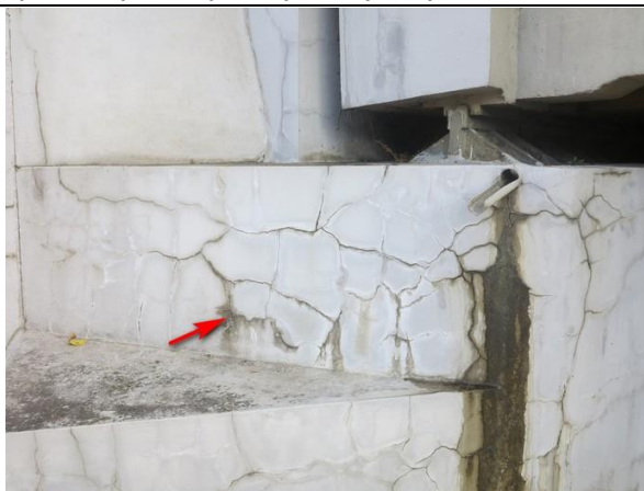
Foto č. 9 - O 02 - z líce vlevo, trhliny s průsaky.
