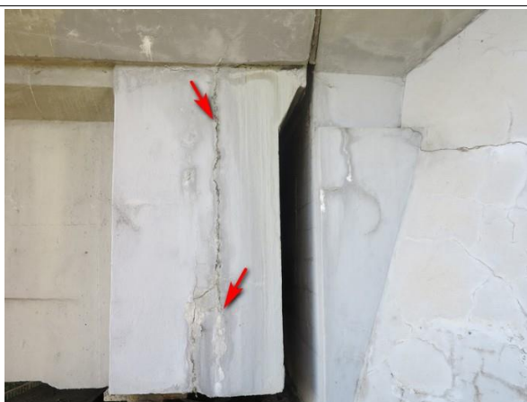
Foto č. 5 - K 02 - kotevní oblast nad O 02 vpravo, svislá trhлина s průsaky a výluhy.
