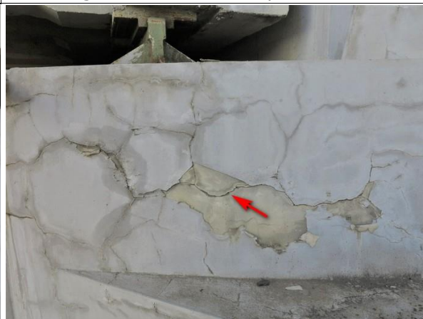
Foto č. 10 - O 02 - z líce vpravo, trhliny i v betonu pod povrchovou úpravou.
