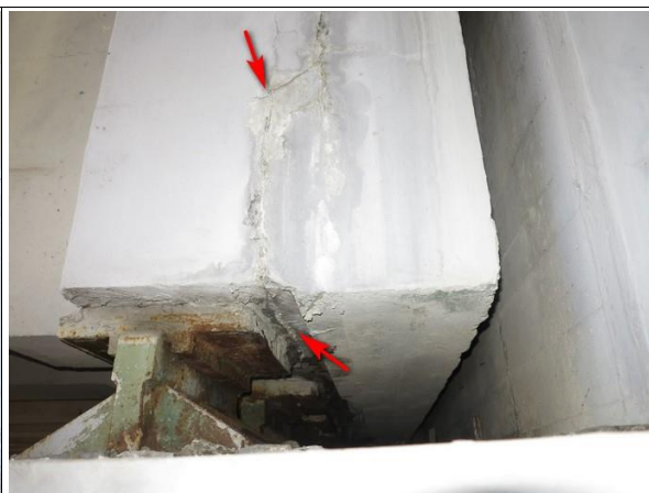
Foto č. 6 - K 02 - kotevní oblast nad O 02 vpravo, poruchy přechází do podhledu.
