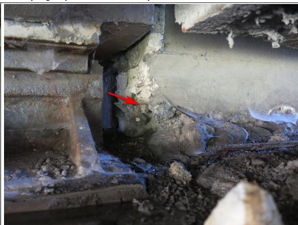
Foto č. 8 - O 02 - závěrná zeď střední část, degradace betonu od průsaku v NK.
